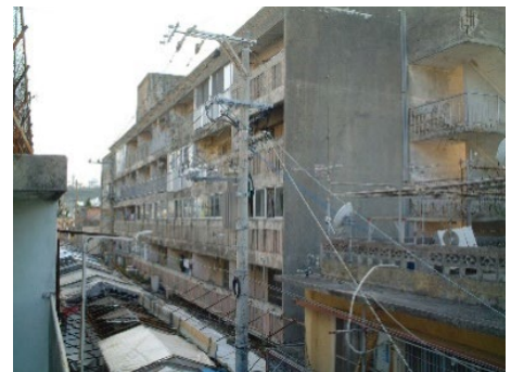
写真－2 老朽化マンションの事例
