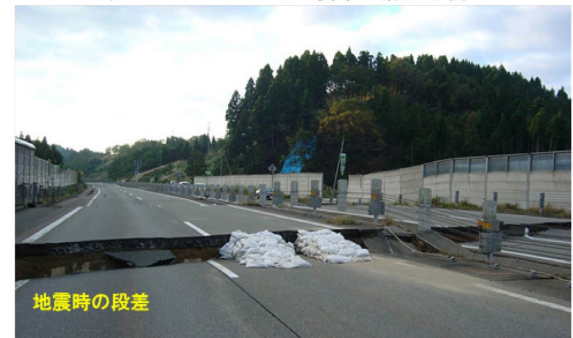
図-4 段差発生事例
