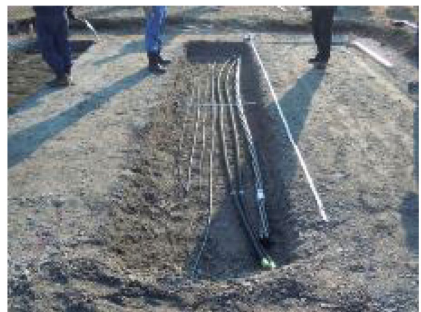
図-8 ケーブルの浅層埋設に関する施工実験
