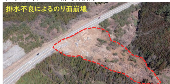
図-3 排水不良による損傷事例
