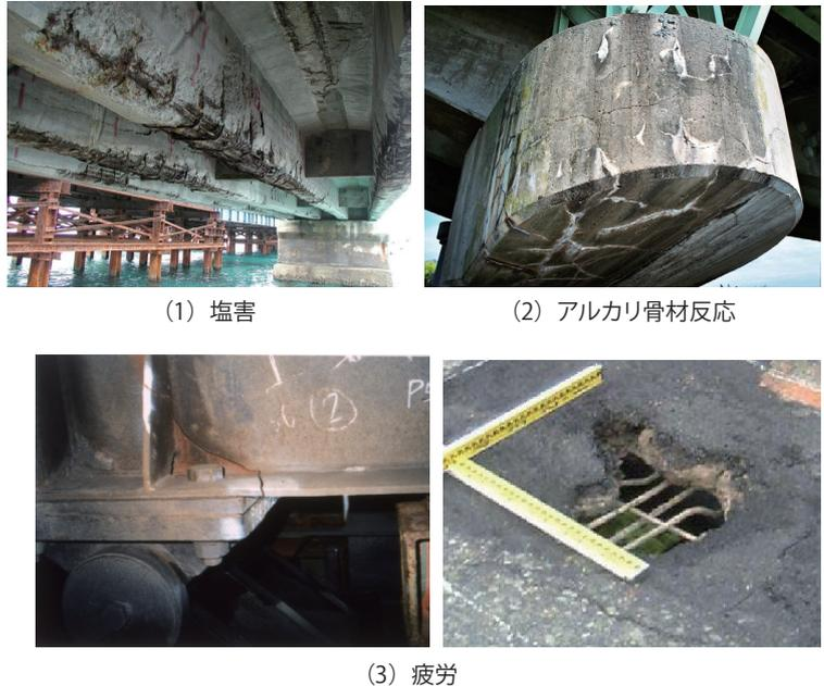
図-4 道路構造物の劣化損傷の例
