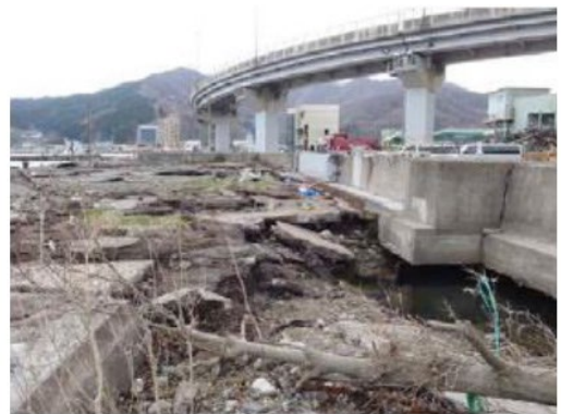
図2 海岸保全施設の被災事例（釜石港海岸）
