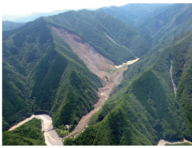
図-3 2011年台風第12号による豪雨で発生した河道閉塞(天然ダム)(熊野川流域五條市 赤谷 2011.9.6 土研土砂管理研究グループ撮影)
