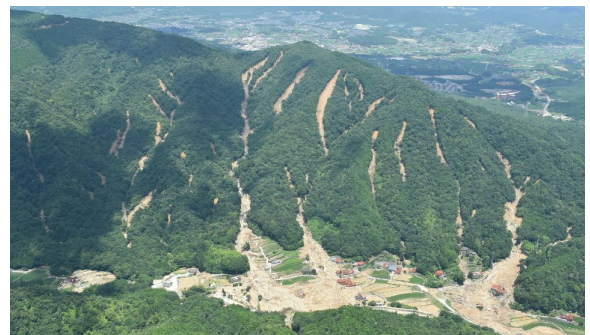
写真-1 花崗岩地域の豪雨による土石流災害の例 (西日本豪雨 2018.7.10 国総研土砂災害研究部撮影 広島県呉市安浦町)
