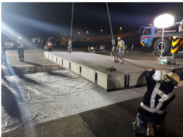
図-5 高強度 RC プレキャスト舗装の施工状況
