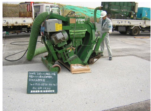
図-6 ショットブラストによる既設舗装表面処理
