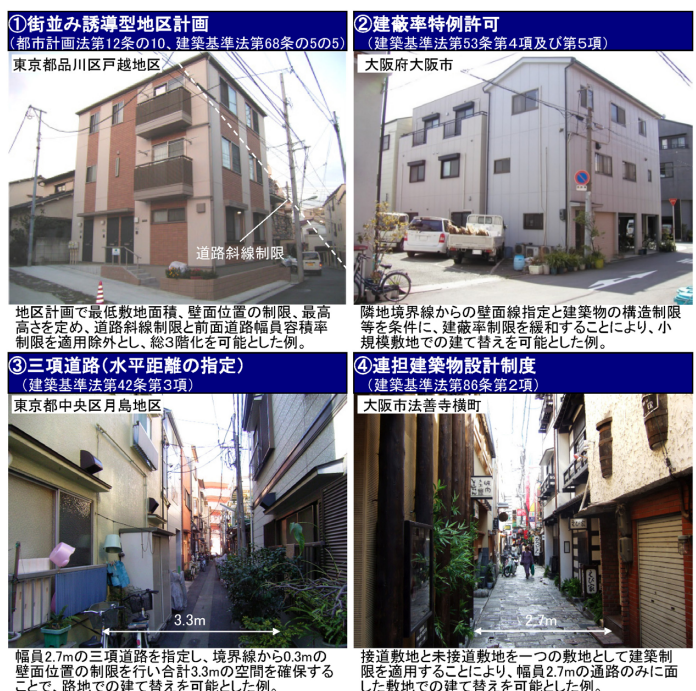
図-4 まちづくり誘導手法を活用した密集市街地での建て替え成功事例
