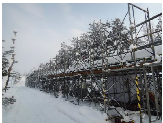
写真-5 実大屋根試験体による屋外実験
