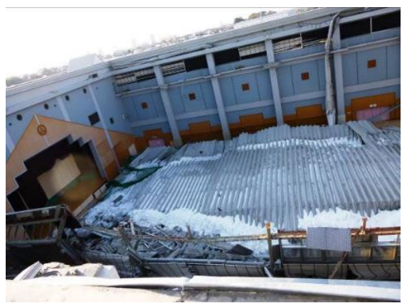
写真-4 積雪後の降雨の影響による大規模屋根の崩落
