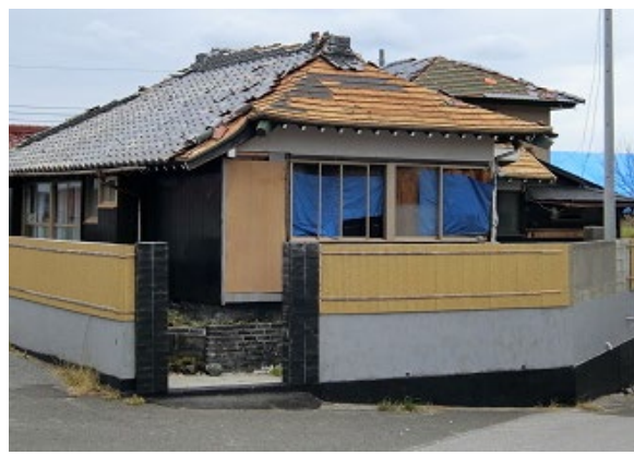
写真-6 令和元年房総半島台風での瓦屋根の被害例
