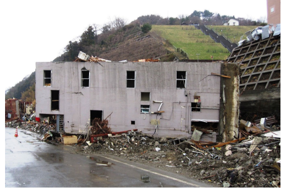
写真-1 津波による4階建てRC造建築物の被害
