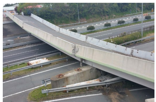
写真-4 ロッキング橋脚を有する橋の被害(熊本地震)
