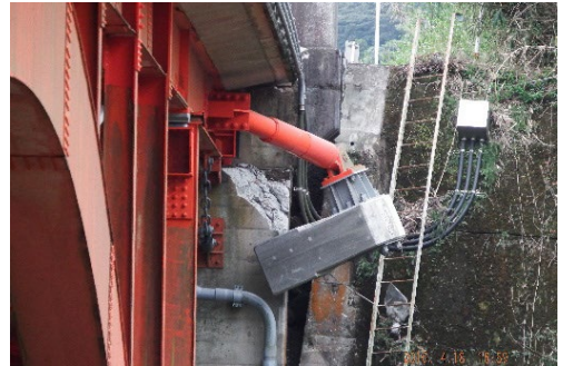
写真-5 取付部の損傷等により機能しなかったダンパー（熊本地震）
