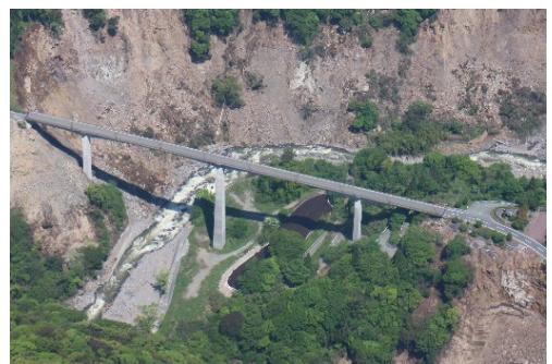
写真-3 地盤変状を受けた橋の被害(熊本地震)
