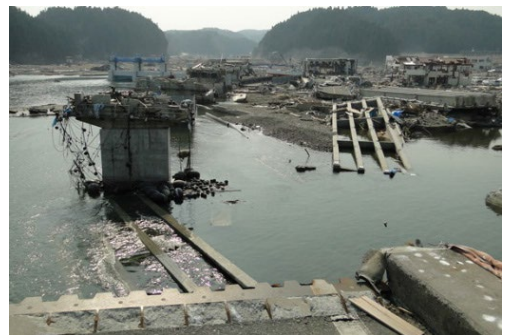
写真-2 津波を受けた橋の被害(東北地方太平洋沖地震)
