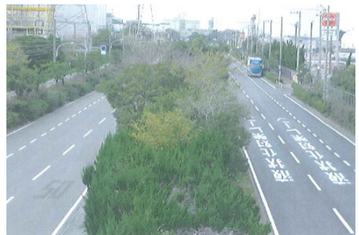
写真-6 液状化対策舗装（大阪府高石市）
