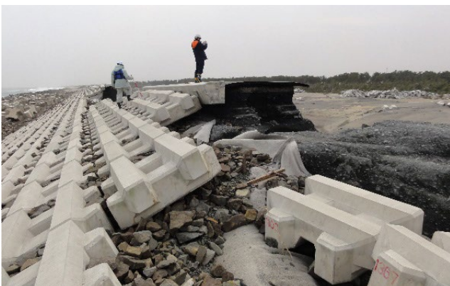
図-1 東日本大震災で被災した仙台湾南部海岸の堤防
