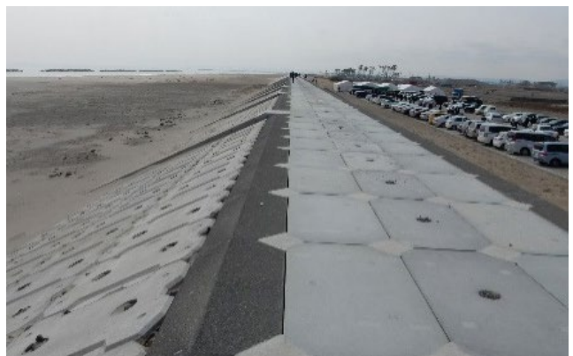
図-2 復旧された仙台湾南部海岸の堤防
