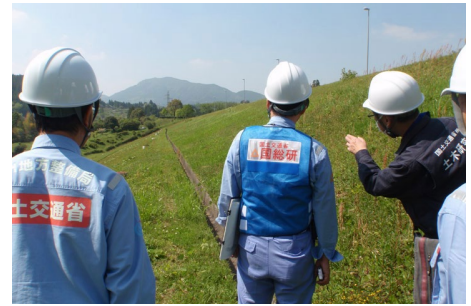
図-4 強い揺れを受けたダムでの安全確認（平成28（2016）年熊本地震 3) ）
