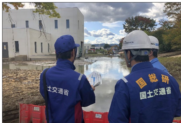
図-4 阿武隈川流域下水道県北浄化センター（福島県）調査状況
