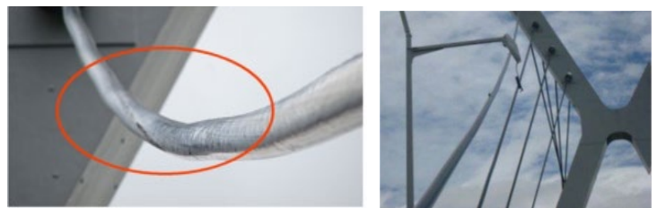
図-9 桑鶴大橋の外観調査で確認されたケーブルの変状状況
