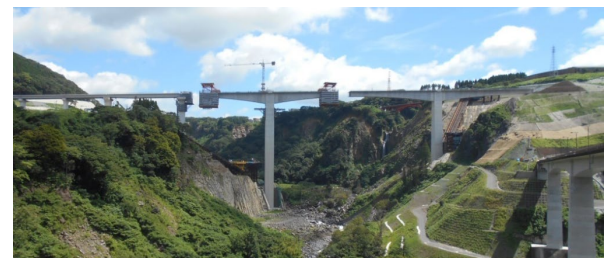
図-6 橋桁の端部が橋脚上でない状態でも橋桁が落ちない状態を保っている新阿蘇大橋（施工中）（写真提供：熊本復興事務所）
