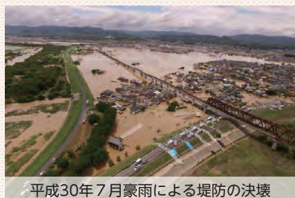
平成30年7月豪雨による堤防の決壊
