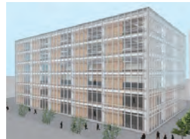
プロトタイプⅡ（S+CLT壁）試設計例
