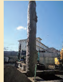
既存杭の撤去工事の状況
