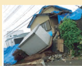
被災した宅地と住宅
