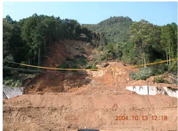
写真-4.1 三重県宮川村小滝地区斜面崩壊状況
