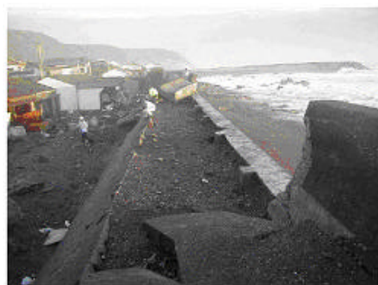
写真-5.3 高知県菜生海岸の被災状況
