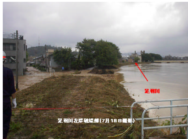
写真-2.1 破堤時状況
