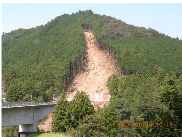
写真-4.2 三重県宮川村小滝地区における斜面崩壊状況
