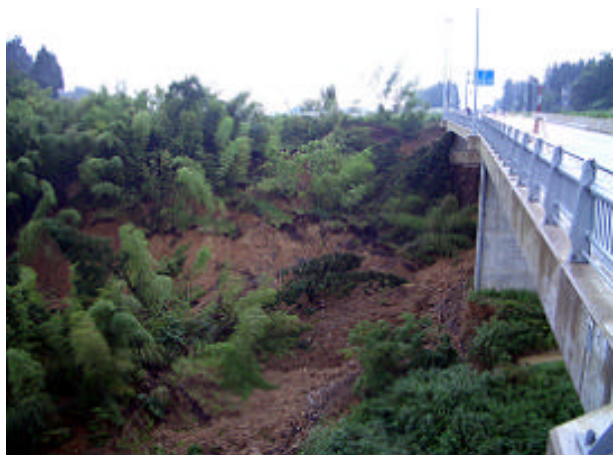
写真-1.6 栃尾市平地区の地すべりのブロックを望む (国道290号栃尾大橋付近)
