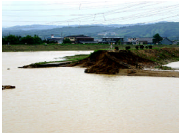
写真-1.1 五十嵐川三条市内の破堤状況
