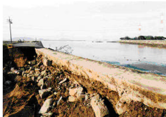
写真-5.2 倉敷市内の施設被災状況
