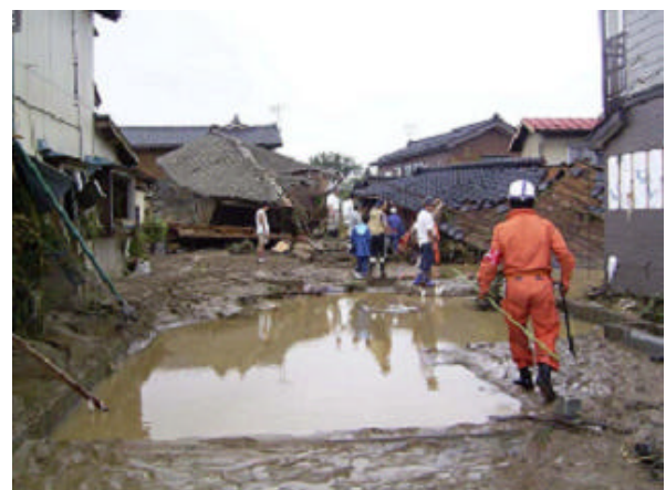
写真-1.4 中之島町内の家屋損壊状況
