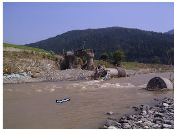
写真-2.2 鉄橋流失 (JR 越美線 第 5 足羽川橋梁)
