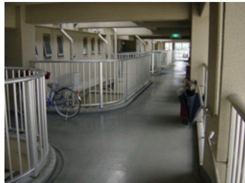
RC造で増築された廊下。中央右にEV出入口がある
