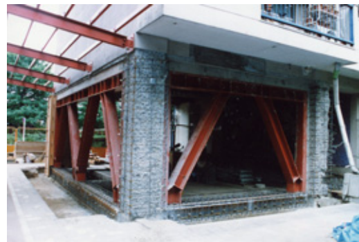
1階のピロティ部分の鉄骨ブレース補強(工事中)
