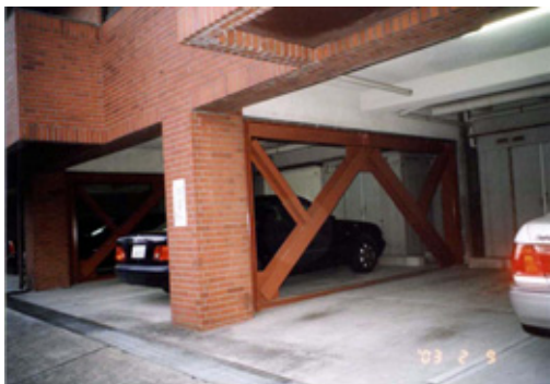
1階のピロティ部分を鉄骨ブレースで補強
