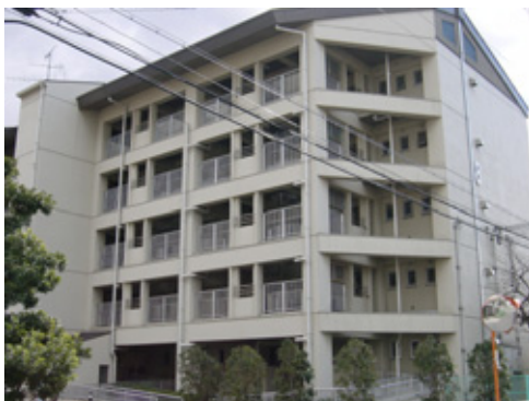
増築部分を北側から見たところ
