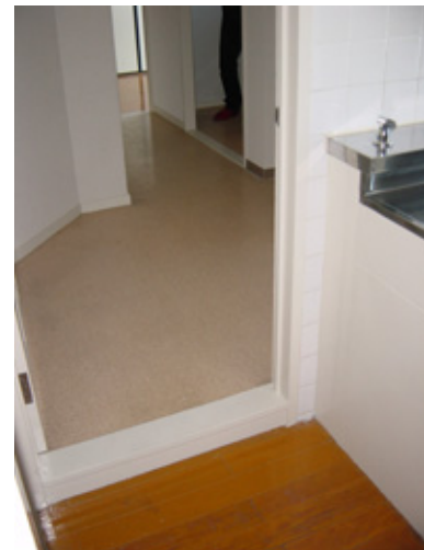
台所から開口した壁を通して見たところ。水回り部は一段高くなっている
