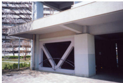
1階のピロティ部分を鉄骨ブレースで補強
