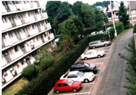
アスファルト舗装の駐車場
