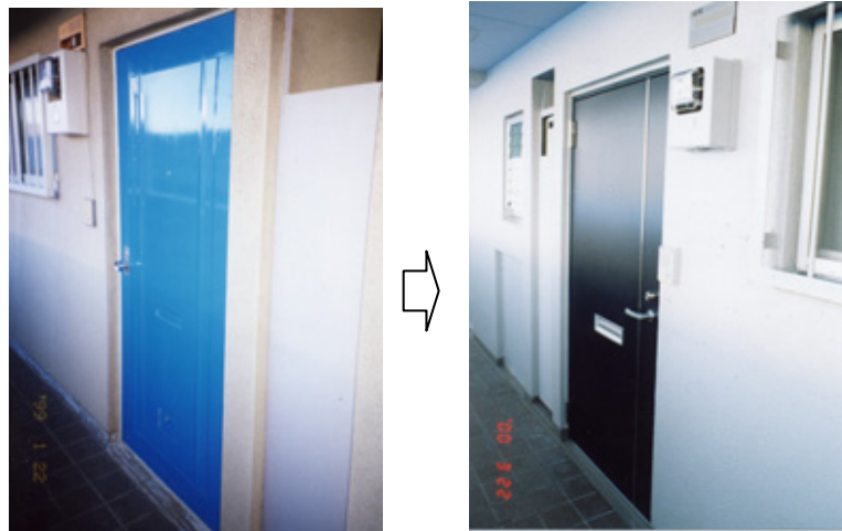
住戸ドアの性能のグレードアップ(プレスドアからフラッシュドアへの取替え)
