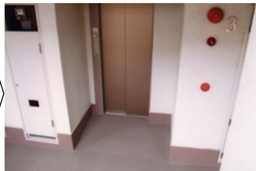
エレベーター出入り口の段差の擦り付け
