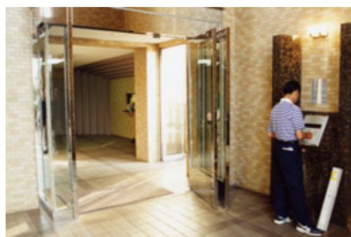
両開き扉をステンレス製片引きオートドアに変更(左)。大型荷物の搬入時には、引き込まれた扉とFIX部が回転して改修前と同じ開口部が確保される(右)。
