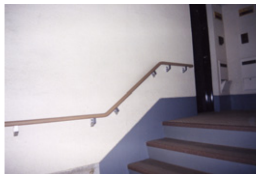
共用階段への手すり設置
