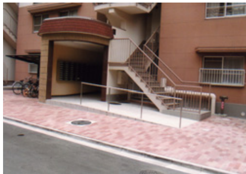
エントランスアプローチ部分の小段差にスロープを設置
