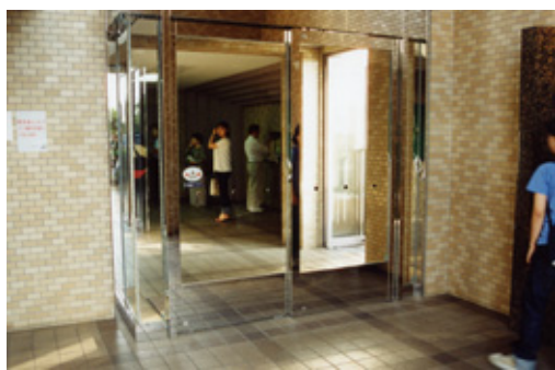
両開き扉をステンレス製片引きオートドアに変更(左)。大型荷物の搬入時には、引き込まれた扉とFIX部が回転して改修前と同じ開口部が確保される(右)。
