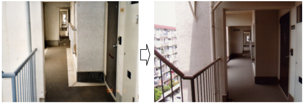
建物の内部廊下床・内壁の仕上げ材料のグレードアップ
