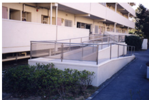
1階共用外廊下へのスロープ設置
