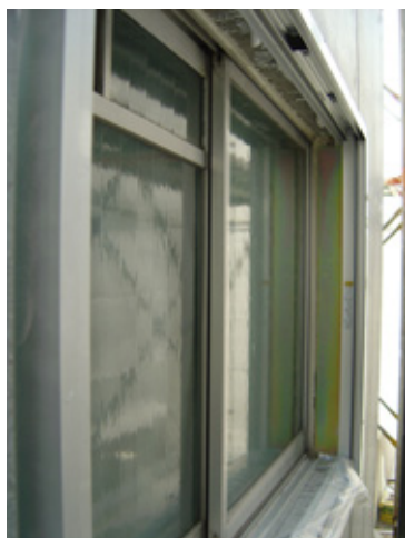
外付け工法による窓サッシの2重化
