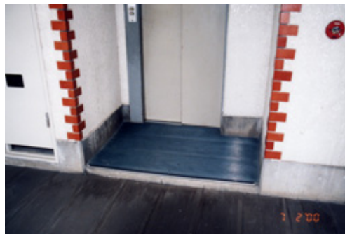
エレベーター出入り口の段差の擦り付け
