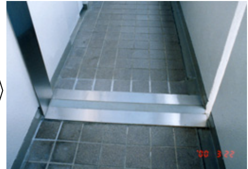
鉄板製の損傷したエキスパンションジョイントをアルミ合金製のものに付け替え
