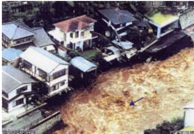
図-5 大場川における浸食状況
