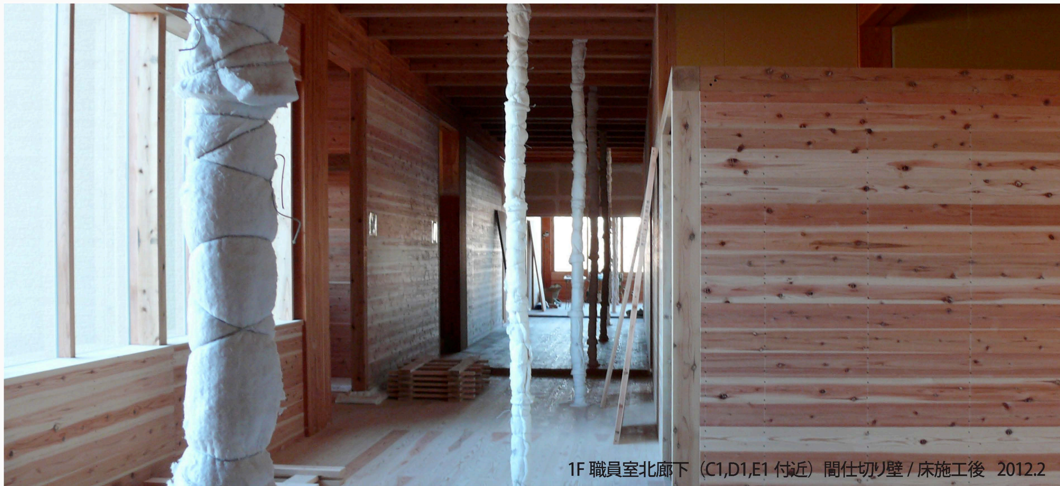
1F 職員室 (E1,F1 付近 / 出火室) 間仕切り壁 / 床施工前 2012.12
