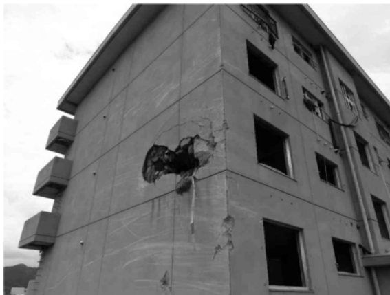
写真 3.1 漂流物の衝突により外壁に局部的損傷が生じたと推測される RC 造建築物
