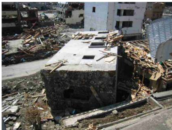
写真 2.3 転倒した杭基礎鉄筋コンクリート建築物 (OG-01)
