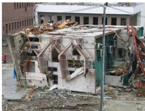
写真 1.1 3 階建て鉄骨造の転倒
