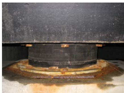
写真4 高減衰積層ゴム支承の状況（B）
