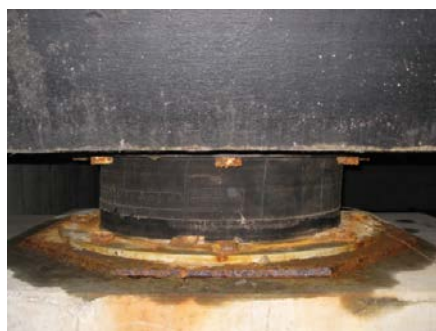
写真4 高減衰積層ゴム支承の状況（B）
