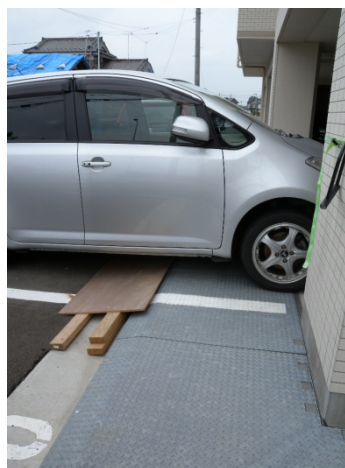
写真11 段差解消の応急措置 (C)
