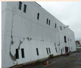
③ 津波による浄化センターの被害 (東日本大震災)
