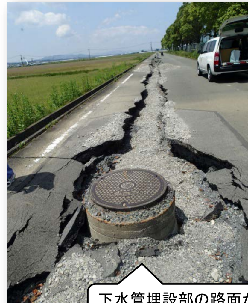
下水管理設部の路面が大きく陥没(益城町)
