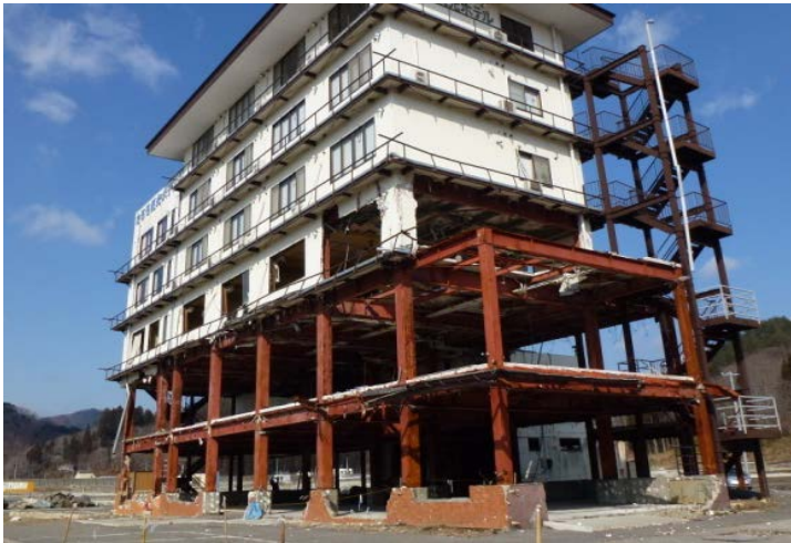
津波による外壁材流失(岩手県宮古市)
