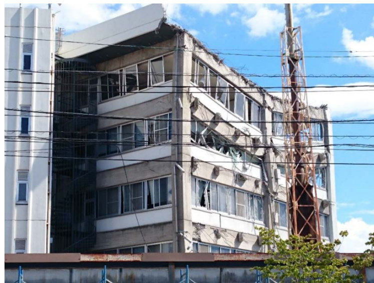
庁舎の被害(熊本地震)
