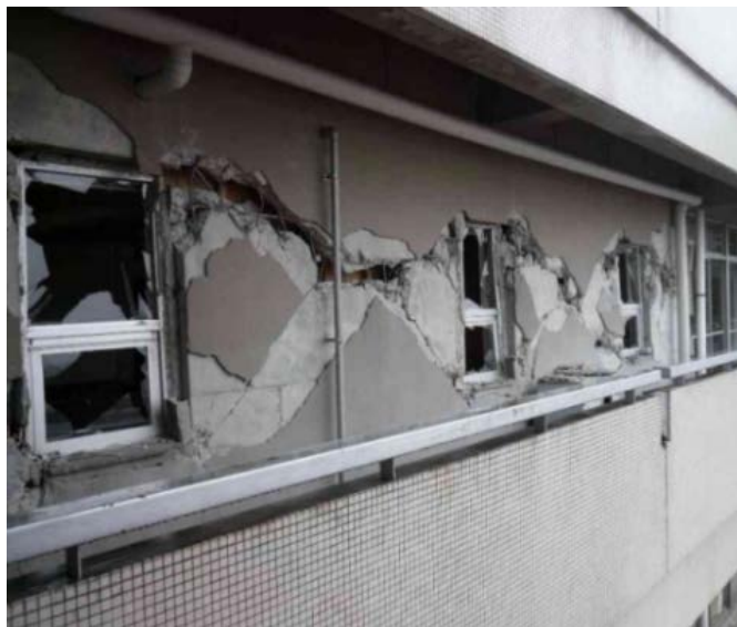
庁舎の被害（東日本大震災）
