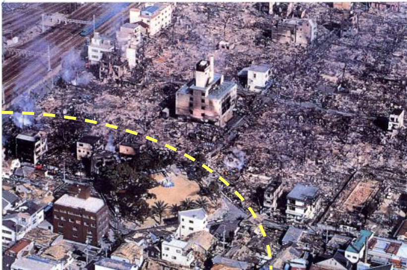
大規模火災の焼け止まりとなった例 大国公園(兵庫県神戸市)
