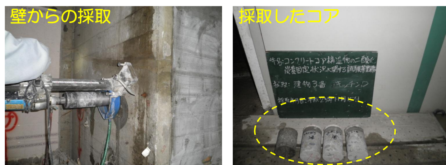
コンクリートコア採取風景(直径10cm×部材厚)
