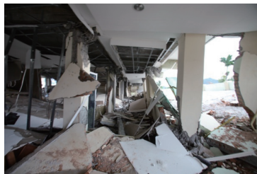
写真1 鉄筋コンクリート柱の座屈・インフィル壁の崩落 (左手：教室側、右手：廊下側) Photo 1. Buckling of a reinforced concrete column and collapse of infill walls (left: classroom right: corridor)
