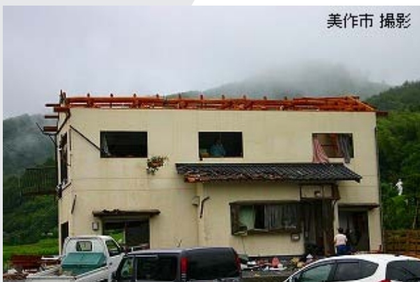
写真 1 小屋組の被害 (美作市)
