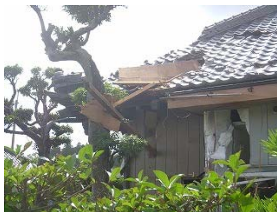
写真6 飛来物による被害（土浦市） Photo 6 Debris impact on envelopes (Tsuchiura city)
