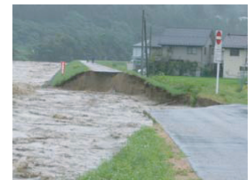
流水の侵食作用による堤防の決壊
