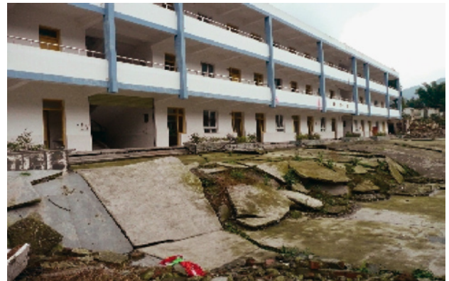
写真-2 白鹿中学校敷地を横断する断層 Photo 2 Fault crossing the site of Pengzhou Middle High School
