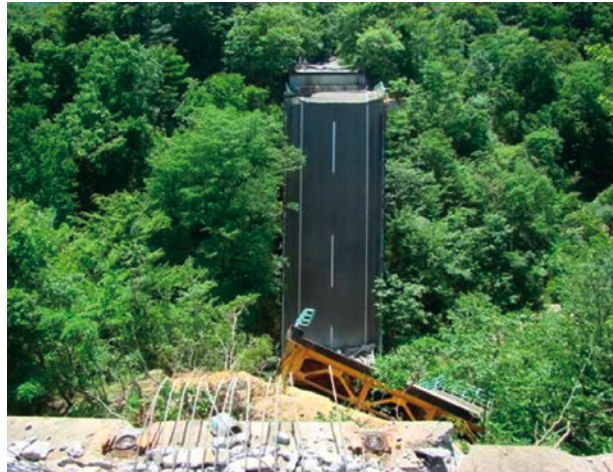
写真-2 落橋した祭時大橋 Photo 2 Collapsed Maturube Bridge
