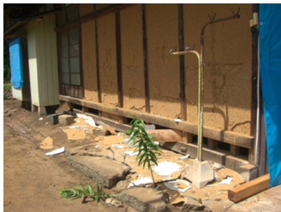
写真-3 戸建て住宅外壁損傷の状況（土壁の落下）
